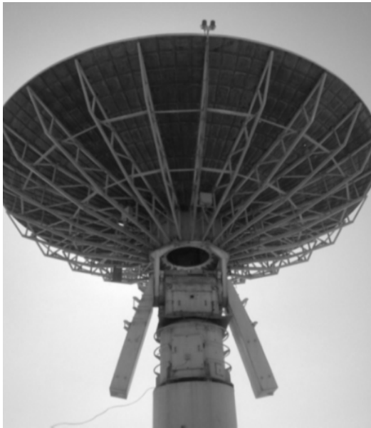
شکل ۶- سازه آنتن سهموی یک ایستگاه زمینی ماهواره‌ای
