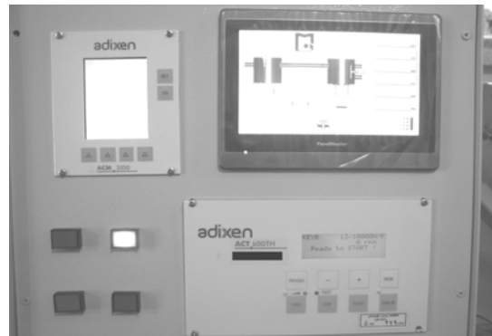
شکل ۱۱- صفحه کنترل سیستم تولید باریکه پوزیترون حرارتی
